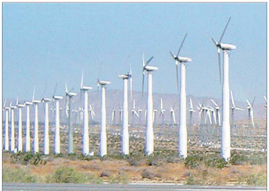
Một trạm phong điện
